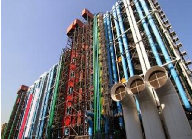
La denominación de **High-Tech** deriva del empleo obsesivo de elementos tecnológicos. Los conductos de ventilación o agua, las escaleras mecánicas, las grúas para la limpieza de los cristales, etc. se evidencian hasta convertirse en un elemento fundamental de la construcción. El cierre de los muros se realiza, por lo general, con cristal reflectante, con lo que se potencia un aspecto brillante y agresivo de alta tecnología. El
